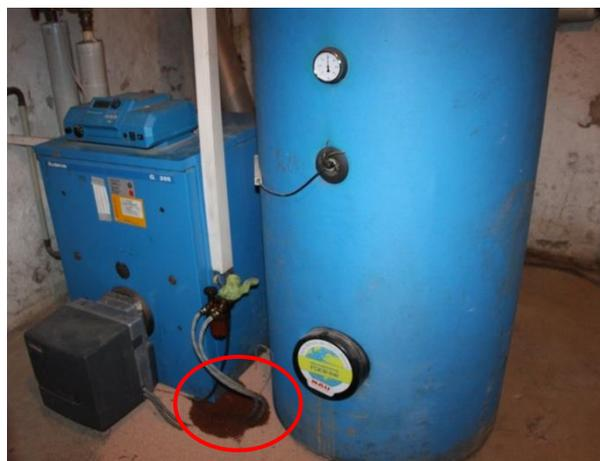
Abbildung 5-9: Ölheizkessel mit Ölleckage.
