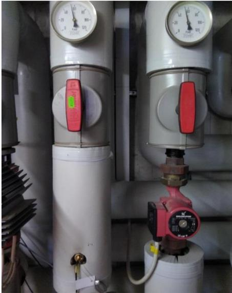
Abbildung 5-11 Heizverteilung mit Temperaturanzeige Vorlauf-Rücklauf und Heizungspumpe.
