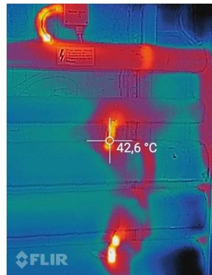
Abbildung 5-12: Wärmebild Rohrbegleitheizung.
